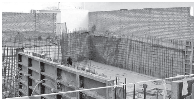
Lám. 16: Calle Cantera Luisa . Ángulo de una construcción en la que se observan infraestructuras arqueológicas cortadas por la excavación, a punto de ser cegadas por el encofrado de la edificación.
