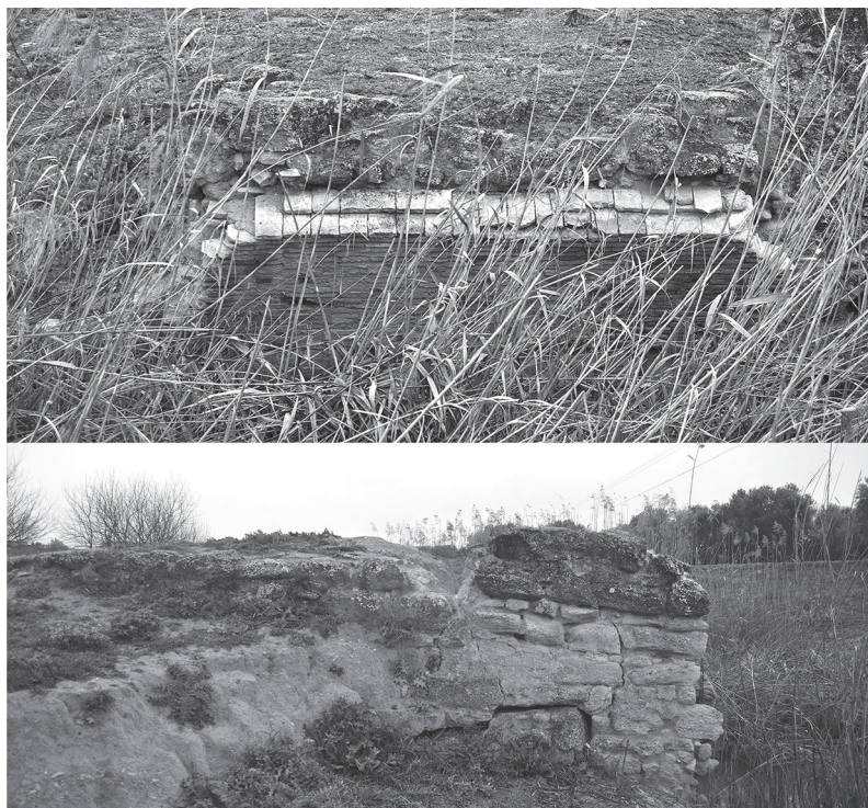
Lám. 8: Vistas actuales del arruinado puente de la Vereda Real de Ronda, en la ribera norte del Salado. Arriba: detalle de los ladrillos del arco. Abajo: restos del lateral derecho (© Pachón 2015).
