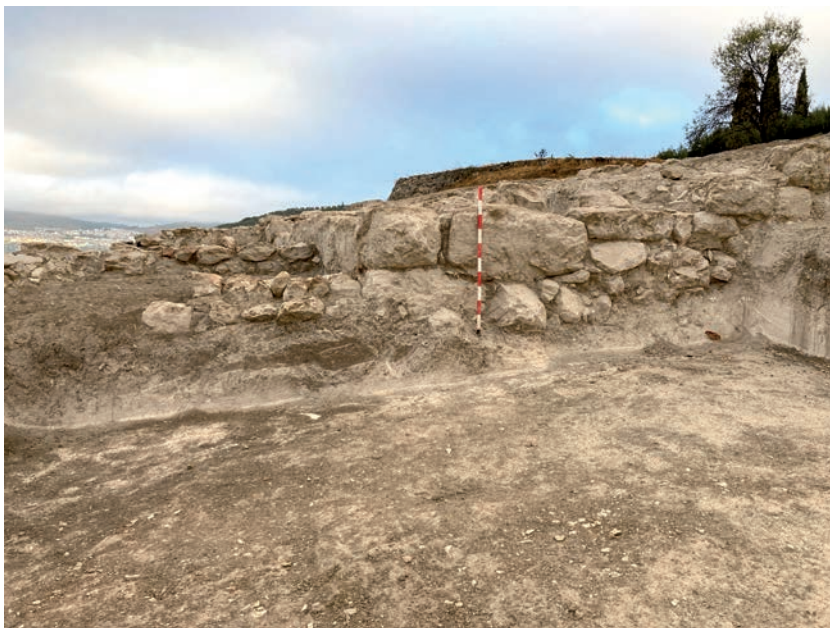
Lám. 7: Detalle de la esquina del edificio 1. Fábrica de sillares almohadillados ciclópeos.
