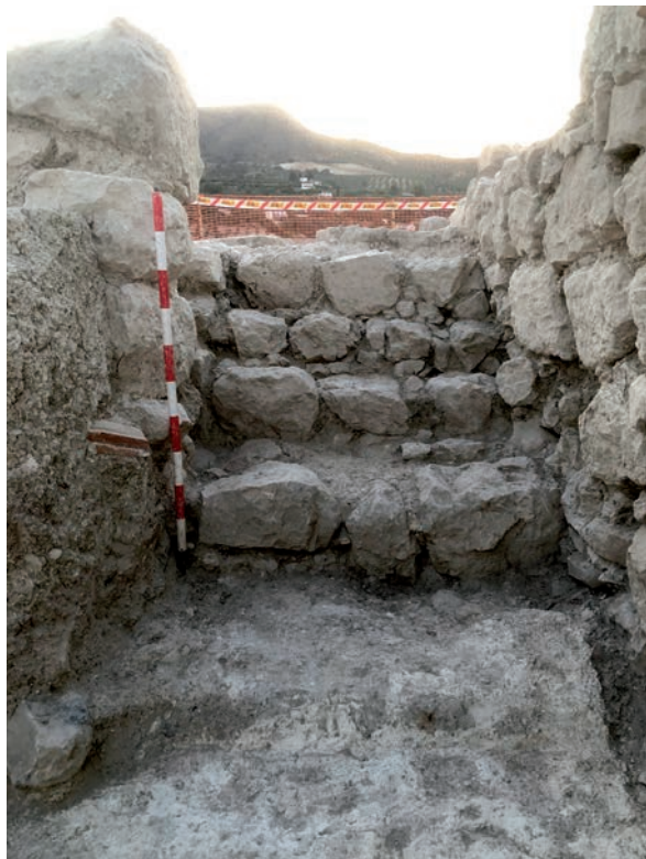
Lám. 19: Escalera de conexión con la sala de prensaado o torcularium.
